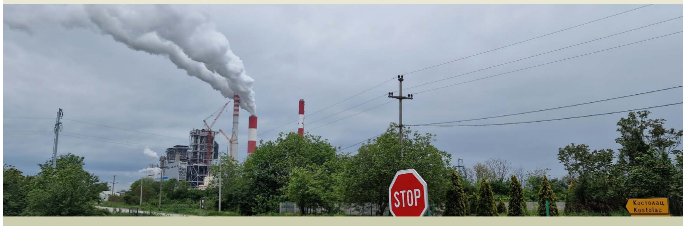
Termo-elektrana Kostolac | Autor: CEKOR, Srbija
