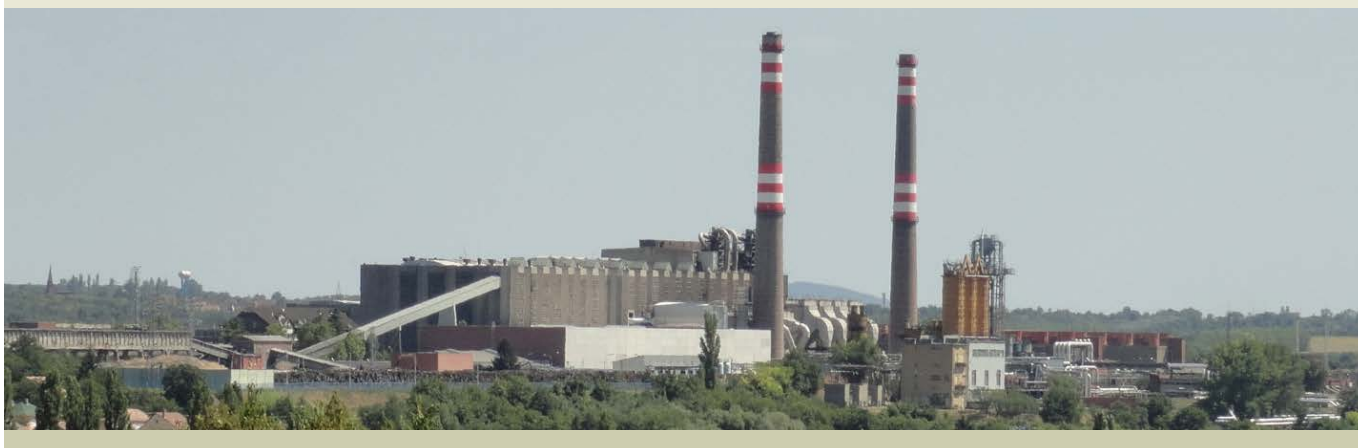
Elektrana Kostolac | Autor: Wikimedia Commons
